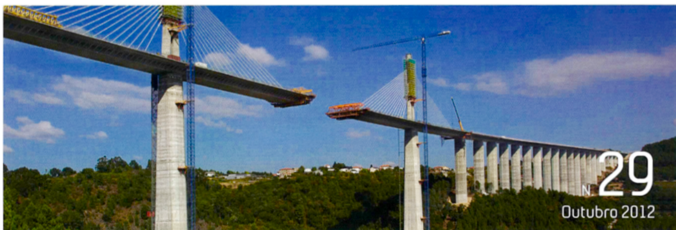
Foto da capa: Viaduto do Corgo, Vila Real - Bragança
